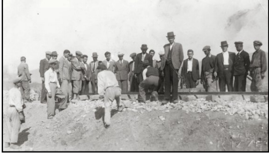
1930 yılları demir yolu yapım çalışmaları (3)
