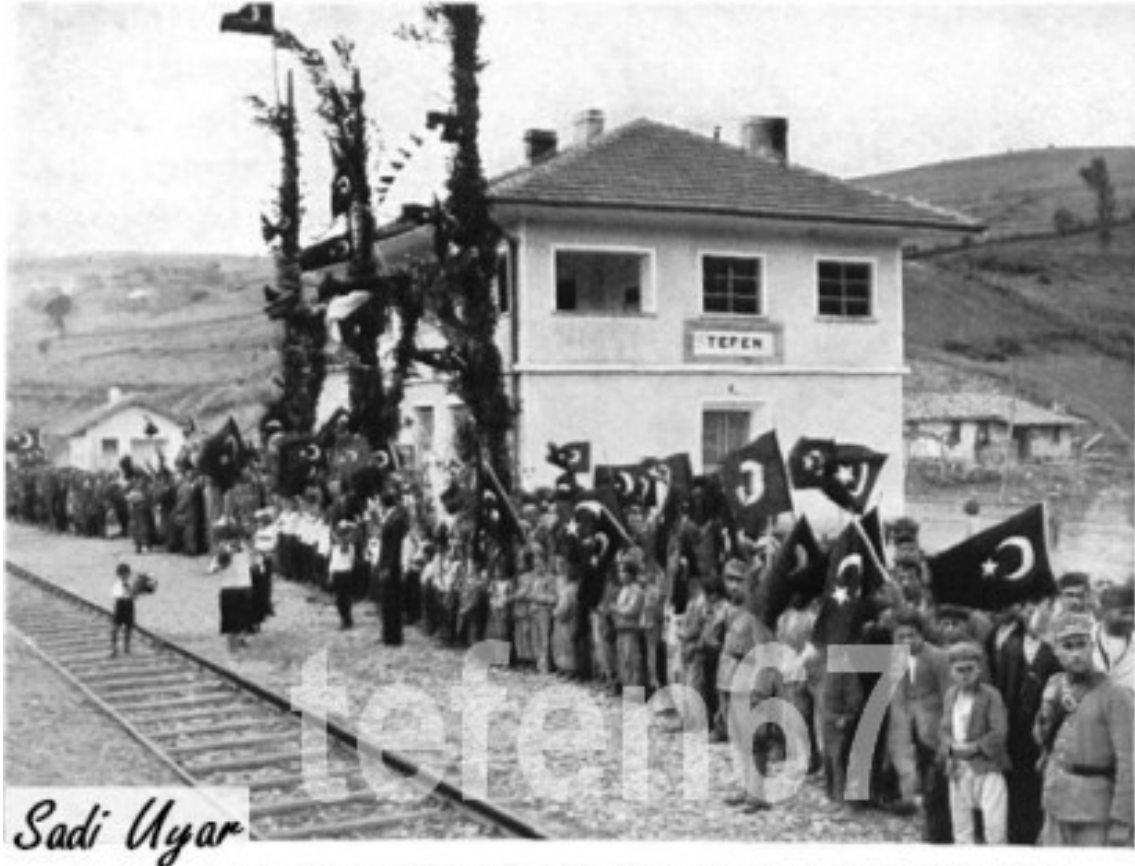
Fig. 61. La station de Tefen, lors de l'inauguration de la ligne Nord, en novembre 1935.
